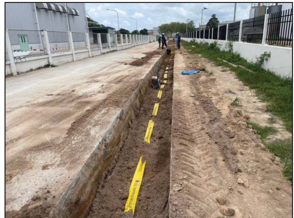
4. ติดตั้งแถบเตือน (Pipeline Warning Tape)
