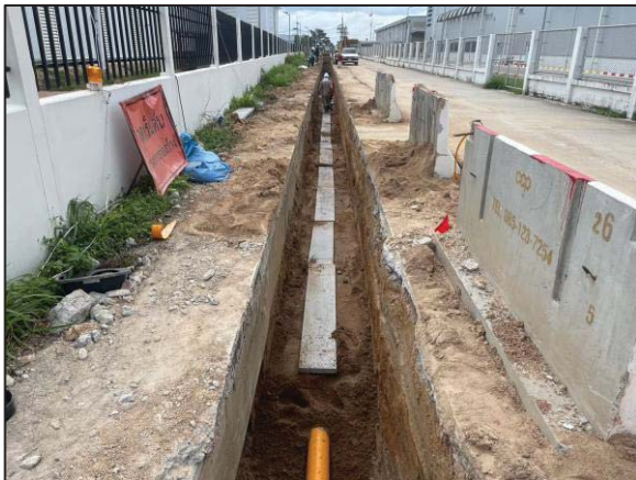
3. การกลบท่อ (Back Filling) และการวางแผ่นคอนกรีต (Concrete Slab)
